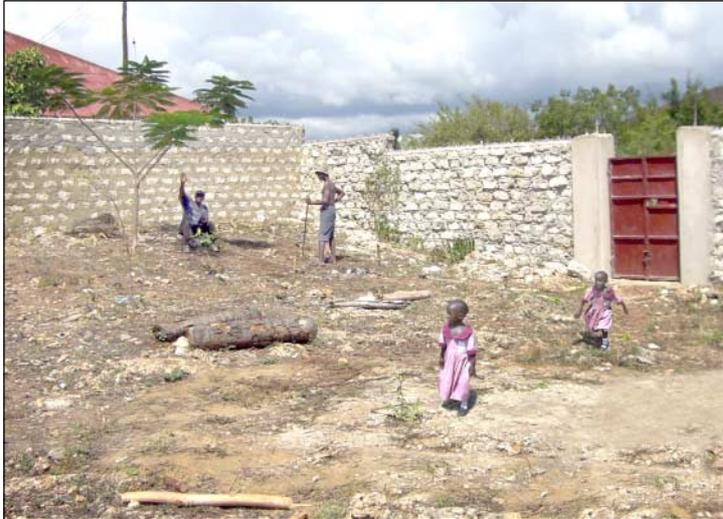
*Dort, wo die beiden Erwachsenen sind, entsteht die Toilette. Der Boden ist Korallenfels und die Bauarbeiter stemmen mit blosser Muskelkraft und mit Hilfe einer spitzen Eisenstange ein Loch, das 2m lang x 2m breit und 8m tief ist.*
