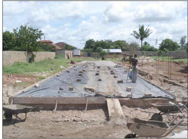
*Oben rechts: nach gut 2½ Wochen war das Fundament fast fertig und betoniert. In Hintergrund sieht man schon die Betonsohle - im Vordergrund arbeiten noch die Elektriker, die Leerrohre im Fundament verlegen.*
